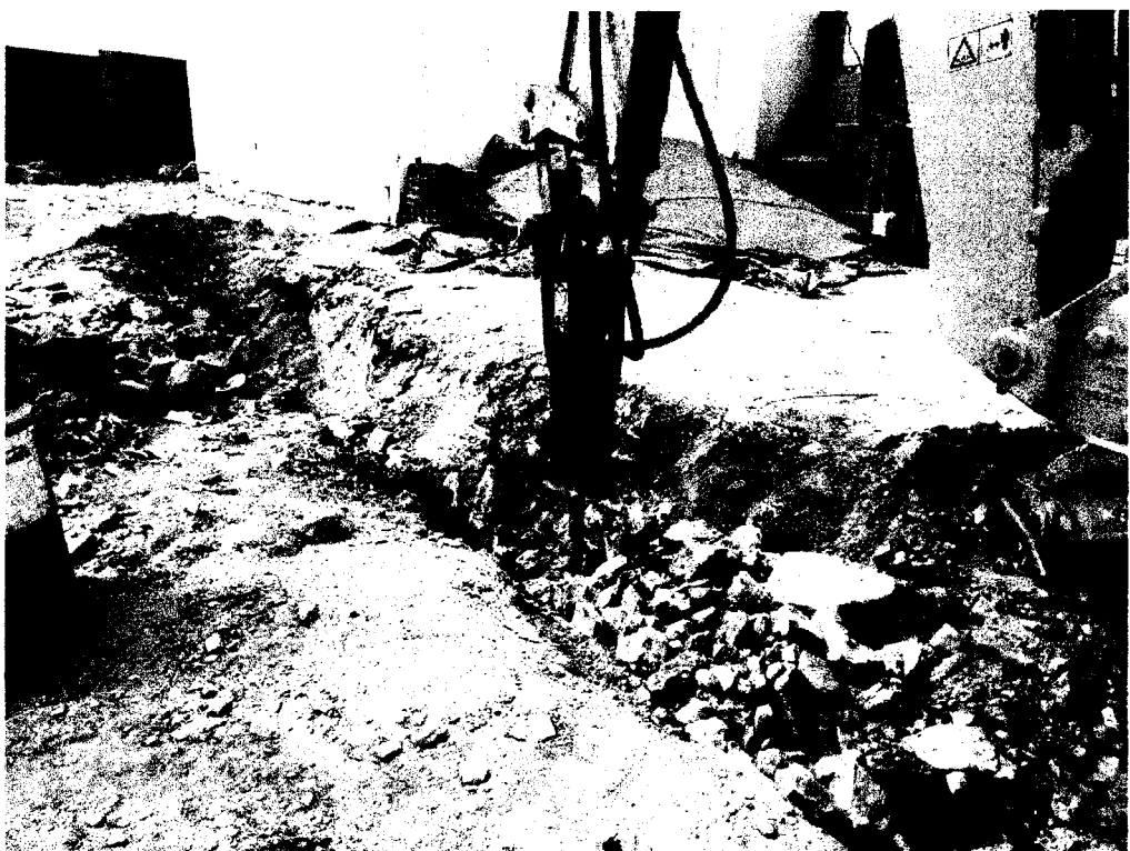
Fig. 01 demolición de vigas de cimentación enterrada en patio de maniobras
